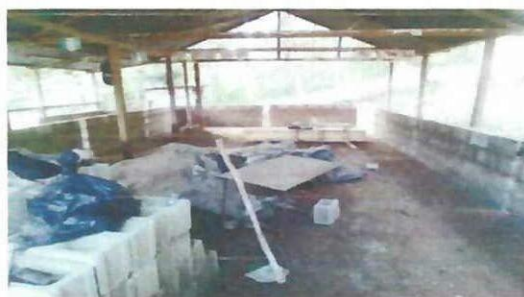
Foto 6: Se necesita continuar las paredes
