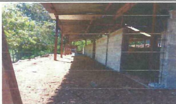
Foto 3: Se necesita colocar puertas y ventanas del establecimiento
